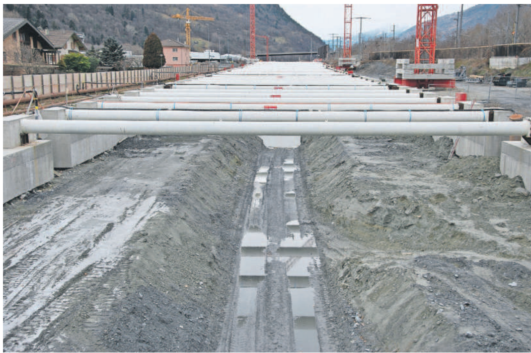
Prägendes Bild. Die tonnenschweren Stahlsprisse werden in den nächsten beiden Jahren dem Gedeckten Einschnitt Raron sein Gesicht verleihen.
